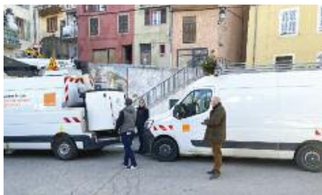
▲ Intervention de l'opérateur Orange sur la commune
