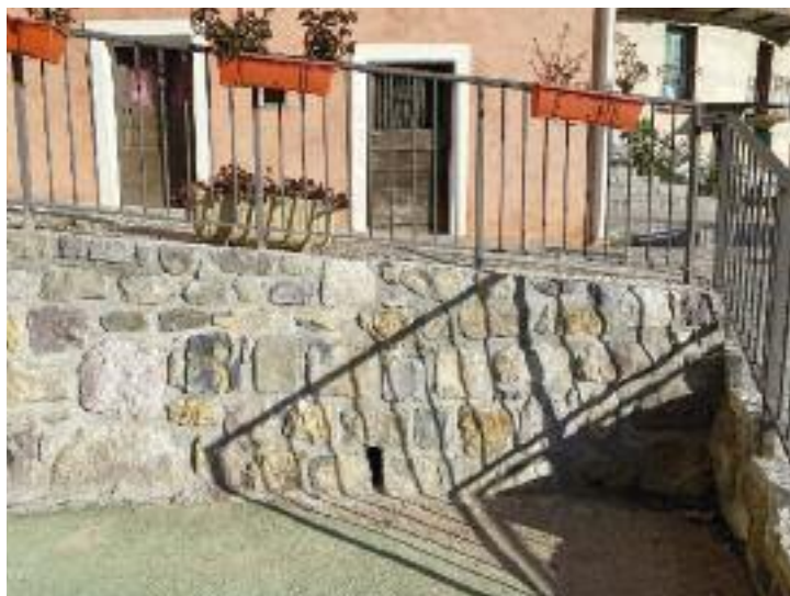
▲ Travaux de réfection du mur de la place Cour
