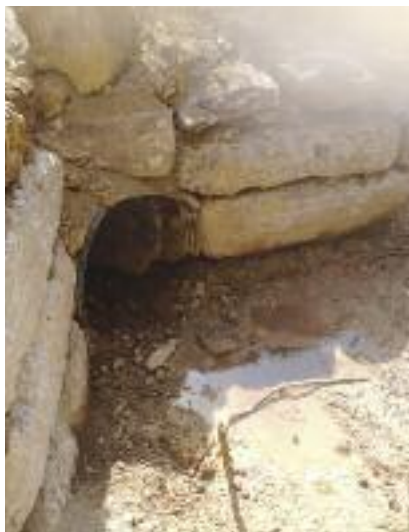
▲ Mise en place d'une buse par FORCE 06 sur la route du Graous
